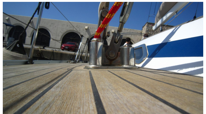
Figura 3: coperta in ottime condizioni
